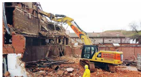
Einer von sechs neuen Cat 340, der für den Abbruchsinsatz maßgeschneidert wurde.
